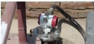
Многоточечный переключатель уровня жидкости с поплавком из нержавеющей стали
