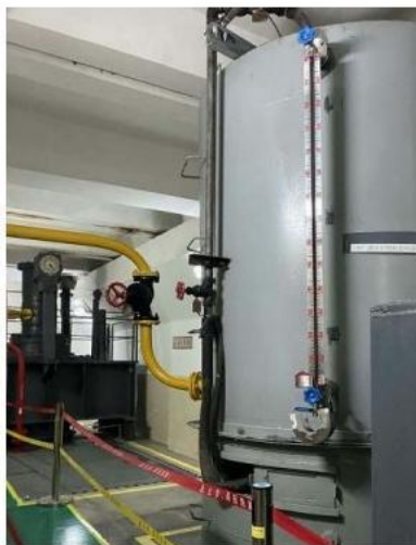
Обычная стеклянная трубка для измерения уровня жидкости
